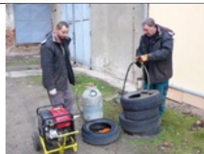
sběr volné fáze dehtů z báze vrtu
