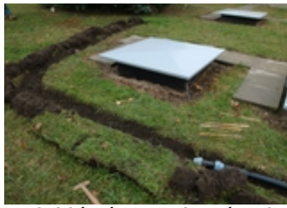
technické práce – zasakovací sondy pod úrovní terénu
