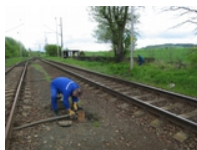
sanační čerpání vrt v kolejí
