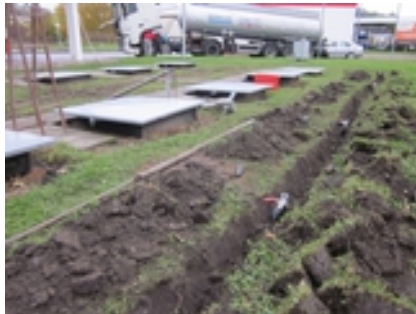
technické práce – realizace rozvodů
